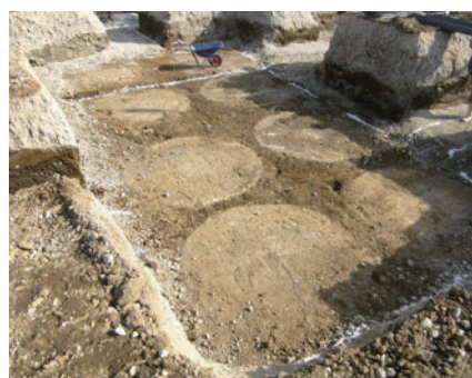
改良体 出来形
