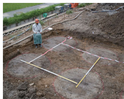
改良体 出来形
