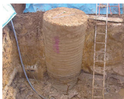
改良体掘起し
