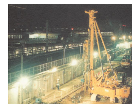
鉄道工事(夜間)
